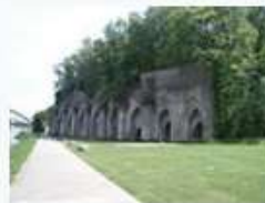
Chercq (Fours à chaux et à ciment naturel).
