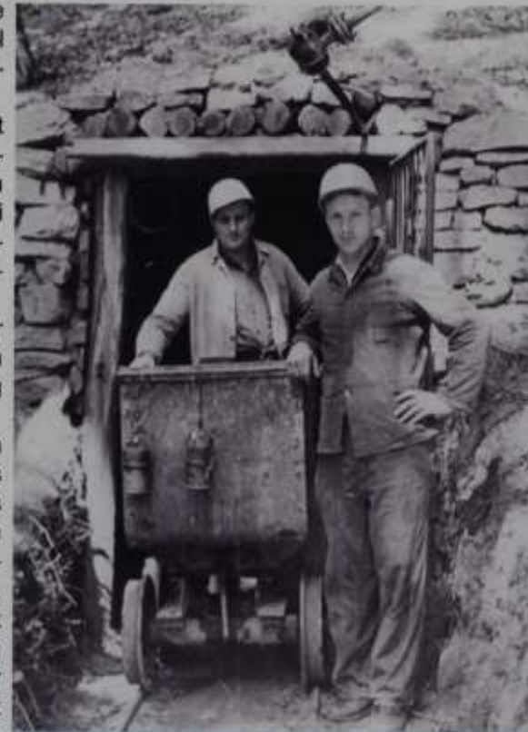
In den 1960er Jahren fanden nur noch Untersuchungsarbeiten am Erichstollen statt.
